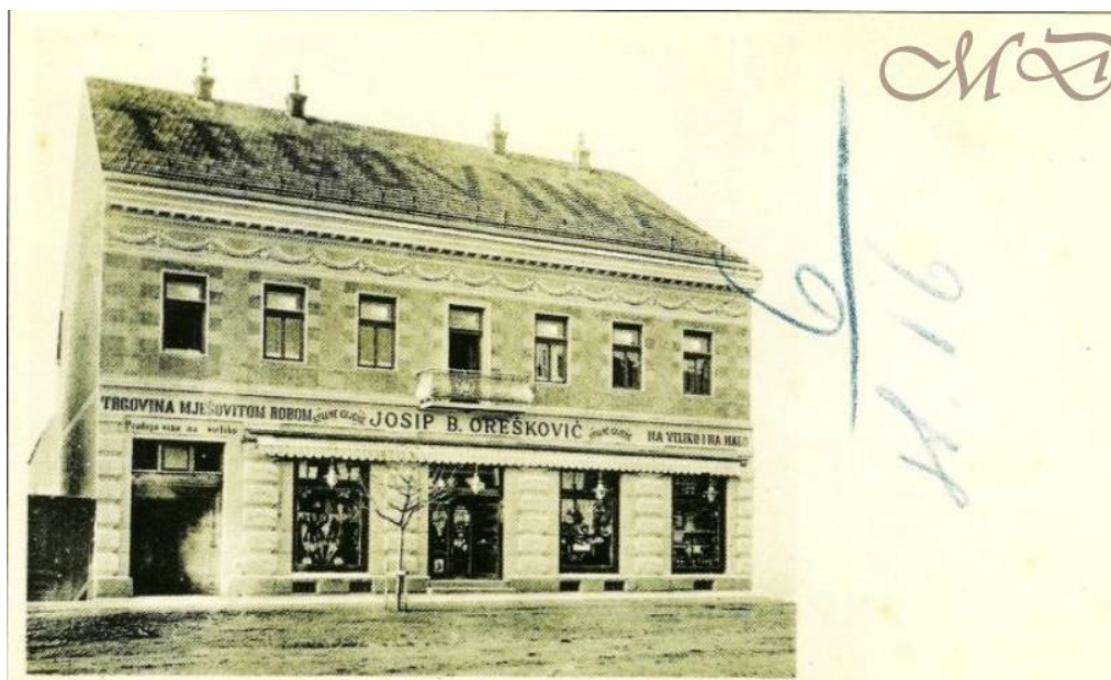
Kuća izgrađena 1906. poznata kao „Špekina kuća“, trgovca Josipa B. Oreškovića, u današnjoj Ulici kralja Zvonimira.
